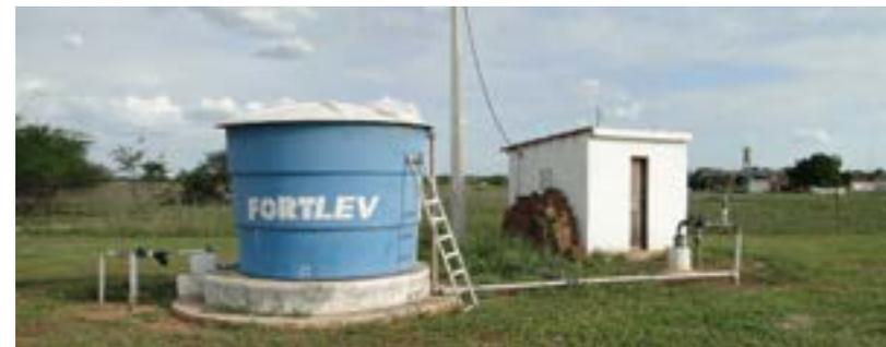
**Figura 66.** Caixa d'água para abastecimento do sistema
